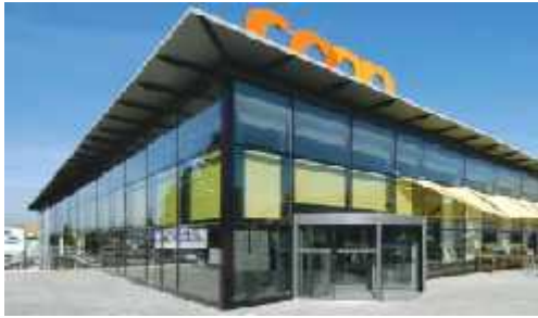
Figure 2.20 : Lignes allongées et transparence des Façades Source : https://archiguelma.blogspot.com
