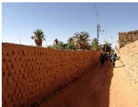
Figure 1.9 : voie secondaire (Zkak) à Timimoun Source : auteur/ 2020
