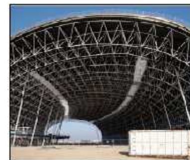
Figure 6.35 : poutres triangulées en arc Source : cahiers-techniques-batiment.fr
