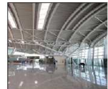
Figure 6.40 : toiture de l'aéroport d'Alger Source : aps.dz
