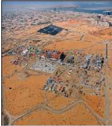
Figure 3.7 : chantier de Masdar Source : utilities-me.com
