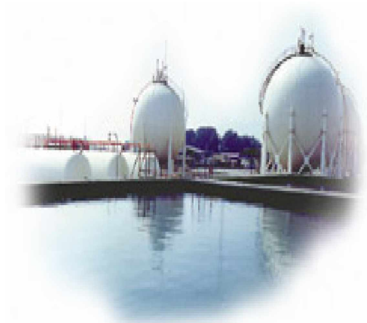
الشكل رقم ( 03 ) : صهاريج لتخزين المنتجات البترولية
