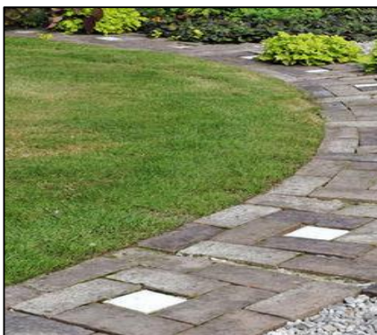
Figure 130 : Le pavé drainé dans le terrain
