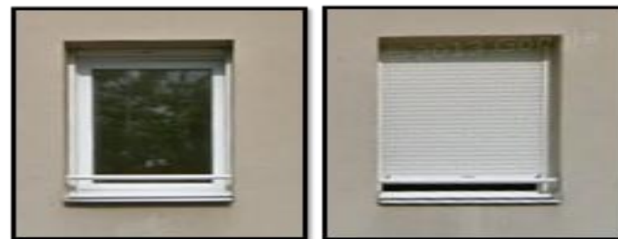
Figure 53 : fenêtres en PVC
