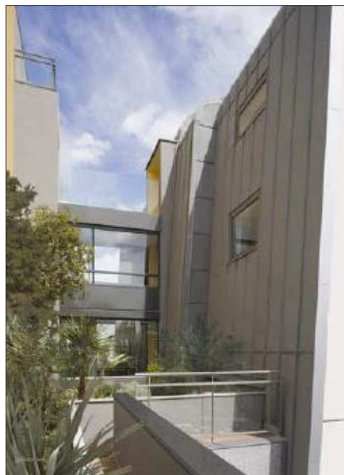
Figure 4 : L'entre-deux immeubles avec passerelles, Frédéric Borel architecte, rue Lagroua Weill-Hallé, Paris 13 e , photo Nicolas Borel.
