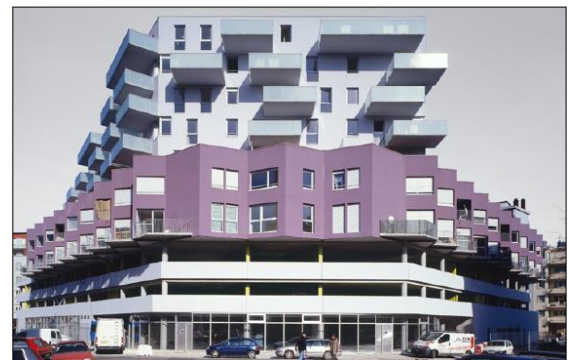
Figure 1 : Démonstration de la mixité par strates utilisé dans les immeubles des logements contemporains
