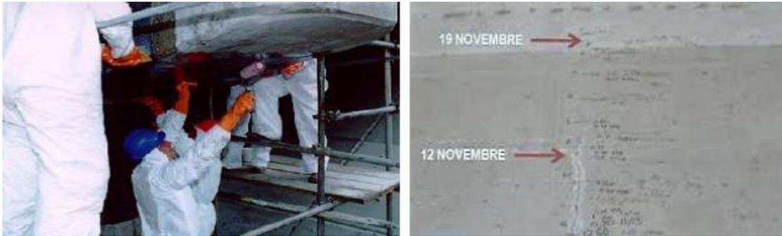
**Figure III.6** Procédure de diminution des fissures
