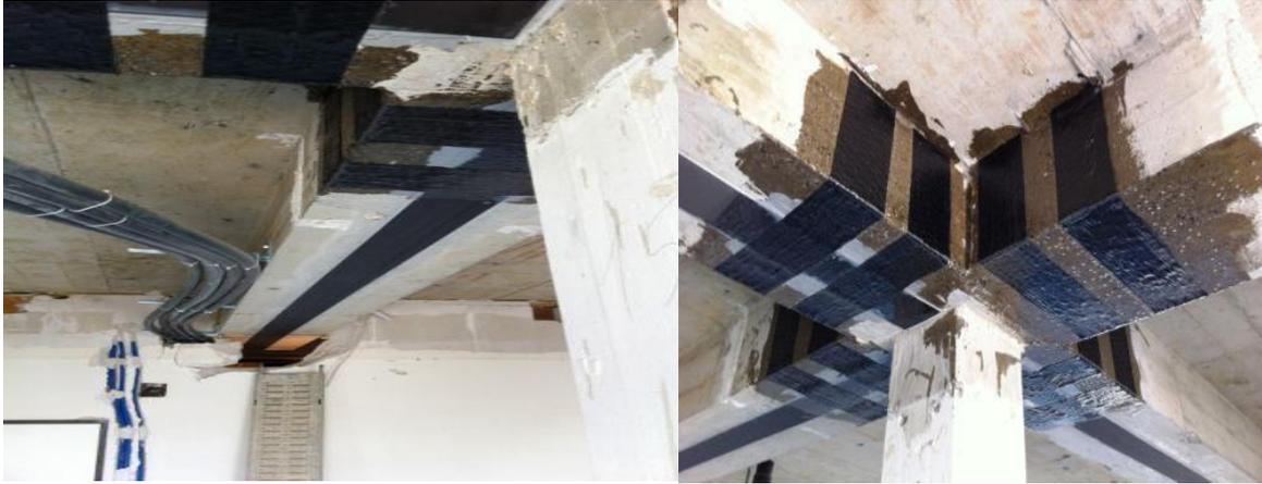
**Figure III.13.** Poutres en BA renforcées par matériaux composites.
