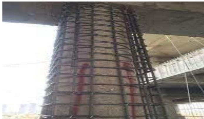
**Figure III.7.** Renforcement d'une poutre avec chemisage en béton armé
