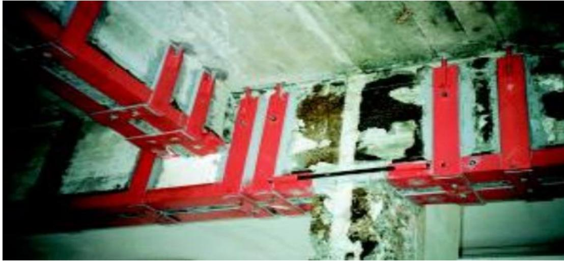
**Figure III.8.** Renforcement d'une poutre avec chemisage en Acier
