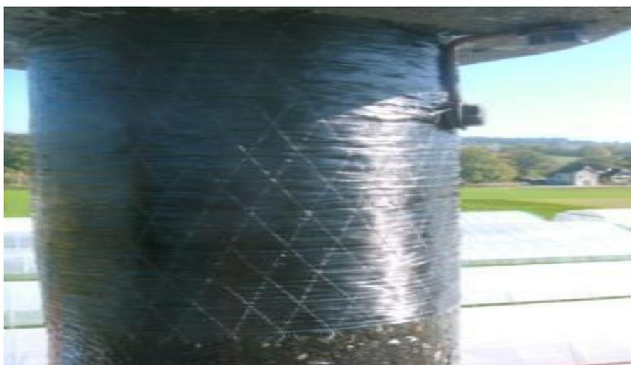
Figure III.12. Poteau circulaire en BA confiné par matériaux composites
