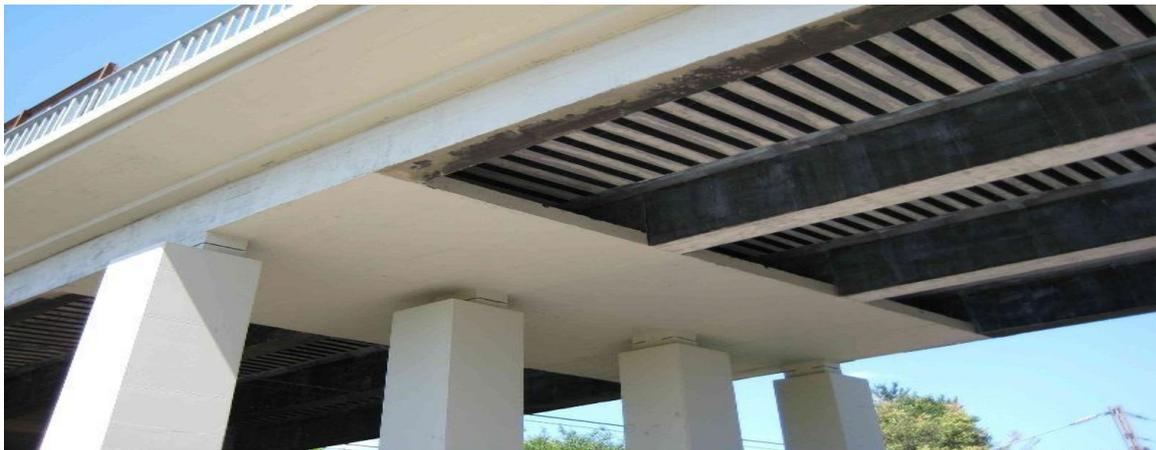
**Figure III.14.** Tablier de pont en BA renforcé par matériaux composites.
