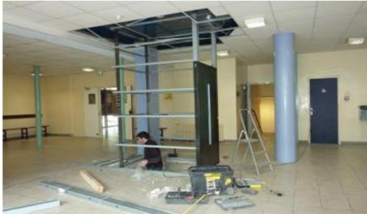
**Figure III.4** Ouverture de passages en dalles pour un ascenseur
