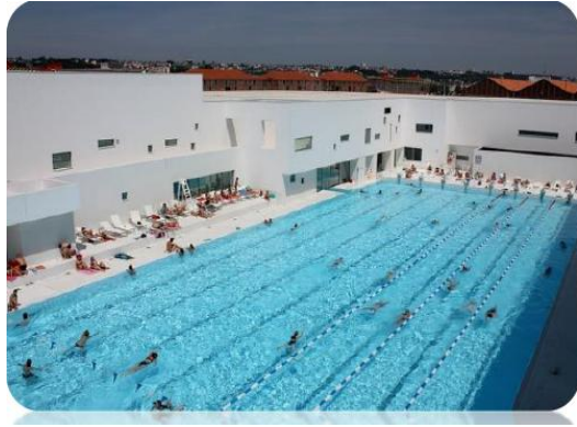
Une piscine extérieure chauffée et sportif de 50m de long par 21m de large
