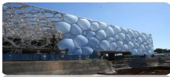
Façade en cour de construction
