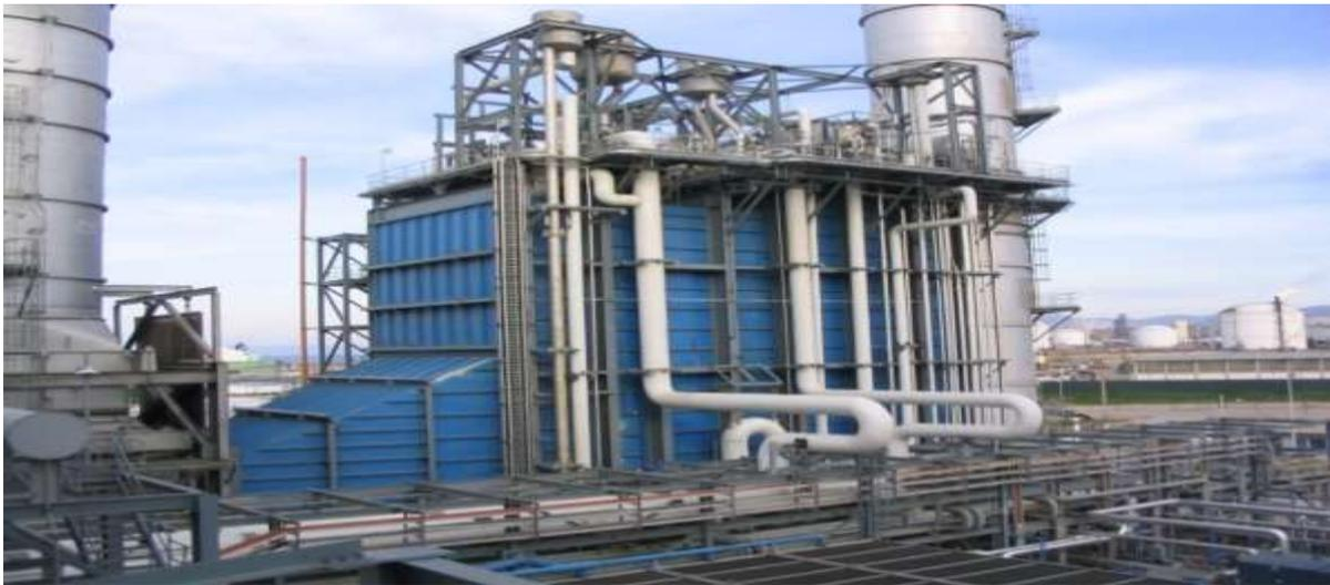
**Figure 1.12 :** Chaudière de récupération de chaleur -Hadjret ennuouss-
