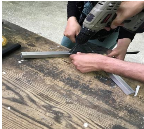
Figure 4-6 : Perçage de structure
