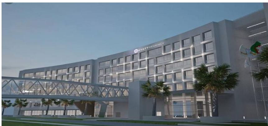
Figure 1.7 : Hôtel Hyatt Regency à l'Aéroport d'Alger,
