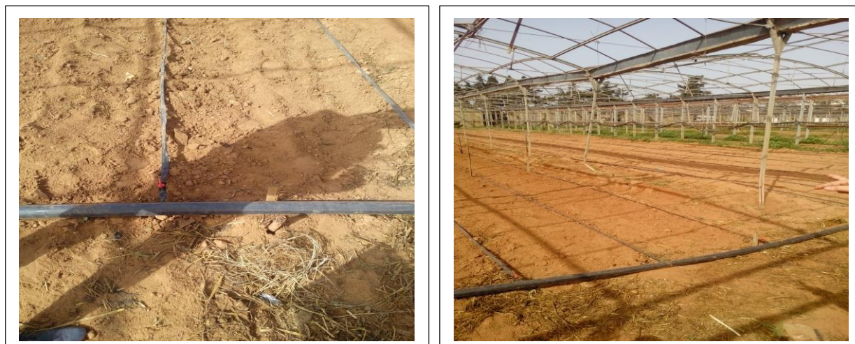
Figure 10 : Réseau d'irrigation goutte à goutte
