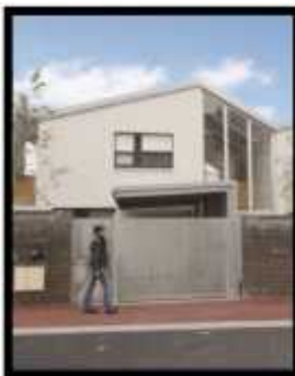
Figure 73: Le traitement de façade Source : HID.
