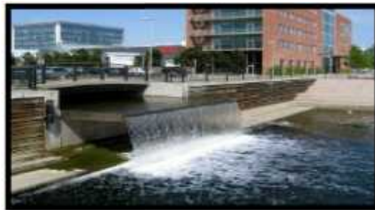
Figure 51: Le traitement des eaux usées. Source : Bo01 "cité de demain"
