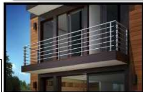
Figure 43: Un balcon d'une maison individuel source : www.alinearchimbaud.fr/avantages-et-inconvenients-des-balcon-en-aluminium/
