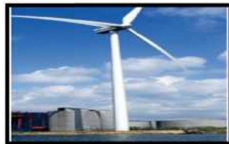
Figure 49: ÉOLIENNE. Source : Bo01 “cité de demain”
