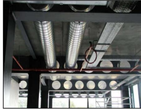
Figure 116 : Utilisation des poutres alvéolaires. Source : ArcelorMittal Europe
