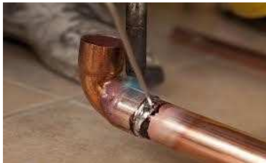
Figure II.18: Brasage des tuyaux en cuivre.
