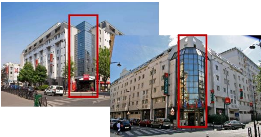
FIG.III.69.70.71 : Façades d'hôtels Source : www.pinterest.com
