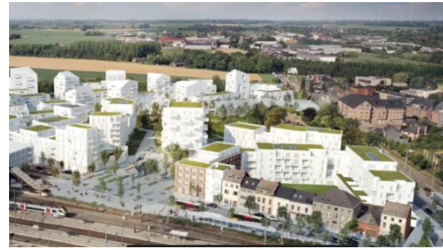
Fig. II.32 : Quartier Gembloux Source : BFP, 2019, enquête publique périmètre de remembrement urbain du quartier de gare public
