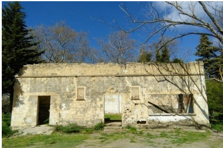
Figure 23 : Ancien laboratoire en ruine (Original, 2017).
