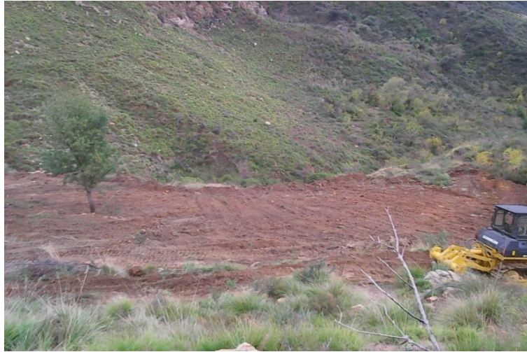
Figure 26 : Ouverture d'une tranchée pare-feu en 2015 (Boumaaza, Com. Pers.).
