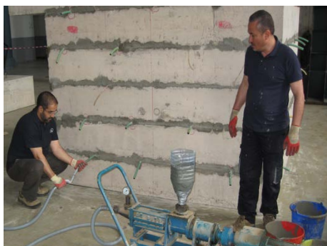
a) Injection du béton entre les plaques de béton
