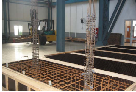
a) Coffrage et pose du ferrailage
