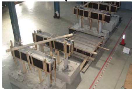
d) Coffrage et Coulage de la poutre
