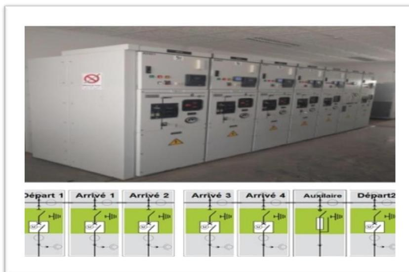
**Figure 3.14. Schéma de la cellule MT de la centrale d'Adrar**
