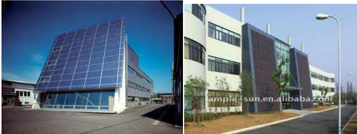
Figure IV.10 : Fixation des modules solaires
