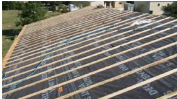
Figure 1.7: Écran souple de sous-toiture constitué d'une feuille plane lisse en polypropylène perméable à la vapeur d'eau et de deux non-tissés en polypropylène [8]
