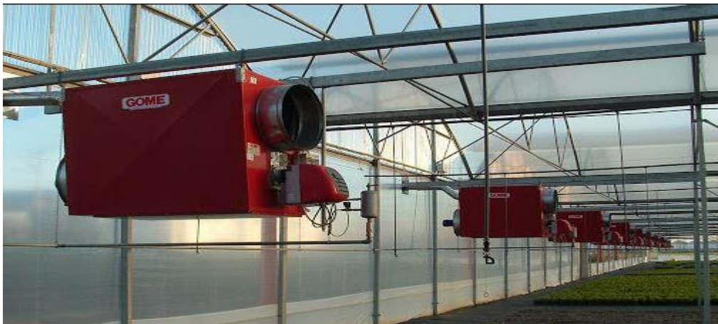
Figure (I-4): Générateur d'air chaud [7]
