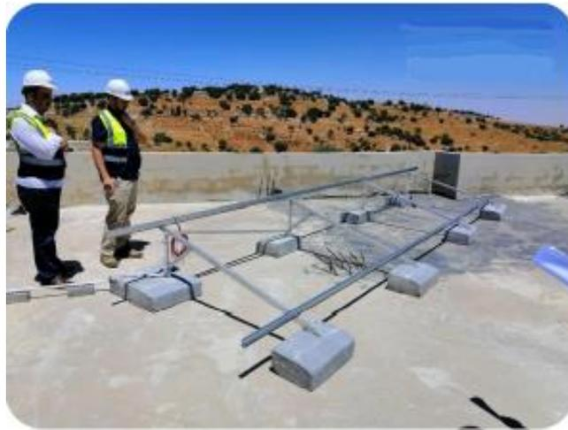
Figure 3-7 : La structure est en aluminium ou en alliage d'aluminium
