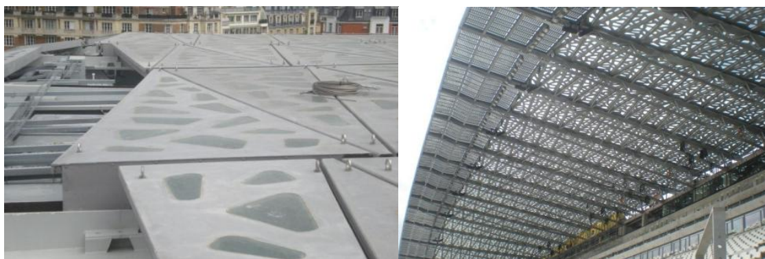
Figure 110: détail constructif en BFUHP.
