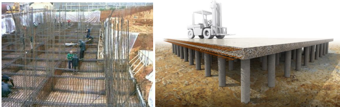
Figure 85 : photographie du chantier de réalisation des fondations
