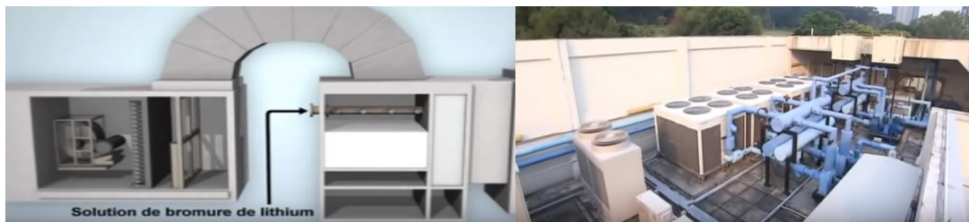
Figure 108: système de climatisation
