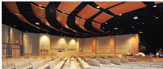
Figure 76:plafond en nuage
