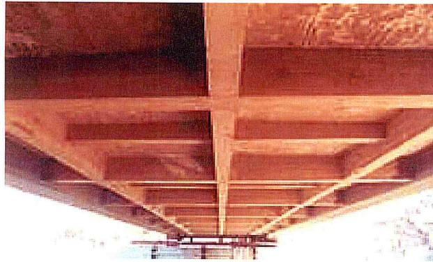
Figure 2.2 : Poutres en béton armé supportant le tablier d'un pont en arc en Tunisie. (Construction de 1931).
