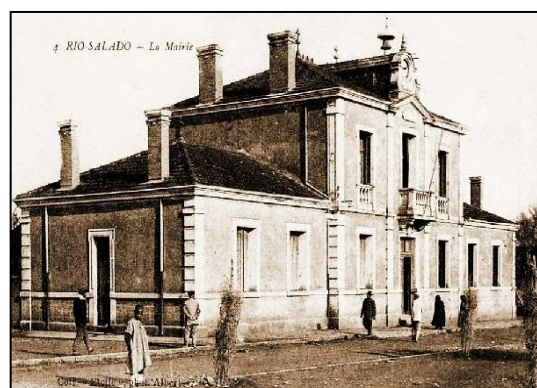
Figure III.5 la mairie de Rio Salado, l'un des premiers édifices de Rio Salado. Source : Amicale de Rio Salado.
