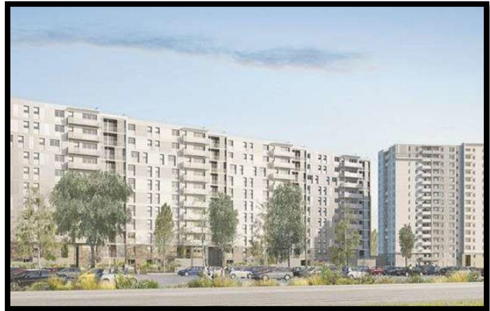
Figure 3 Figure Habitat collectif Source : lemoniteur.fr
