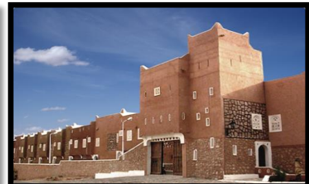
Figure 71 Photo du ksar de Tafilelt, source : Google image
