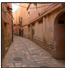
Figure 54 Photo d'une des voies tertiaires, Source : Google image
