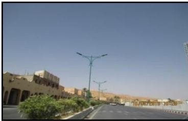
Figure 50 Photo d'une des voies secondaires, Source : Google image
