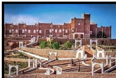
Figure 72 Photo du ksar de Tafilelt, source : Google image
