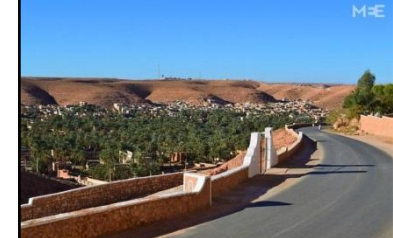
Figure 48 Photo d'une des voies secondaires, Source : Google image
