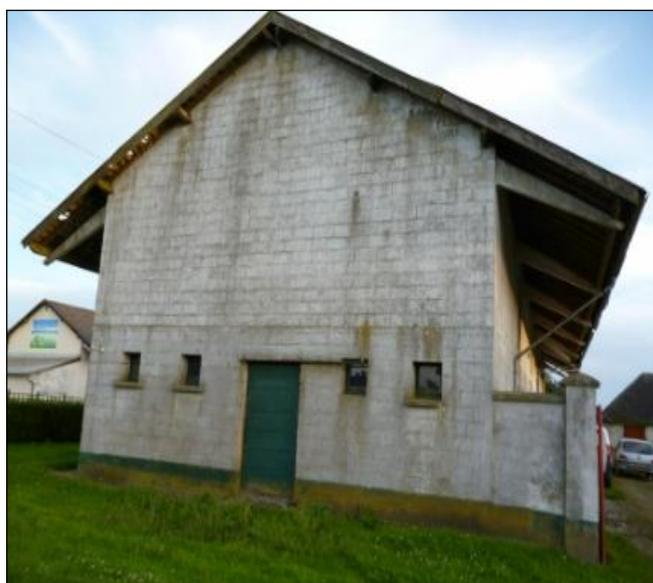
Figure 4.17 : Ferme de Siracourt, élevée en parpaings et couverte d'une toiture en fibrociment sur charpente en béton.
