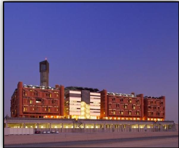
Figure1. 14 : vue du Masdar Institute, on aperçoit les panneaux solaires sur les toits et la tour à vent
