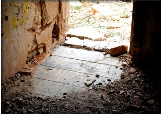
Figure 48: pavé de dalles en béton au rez-de-chaussée
