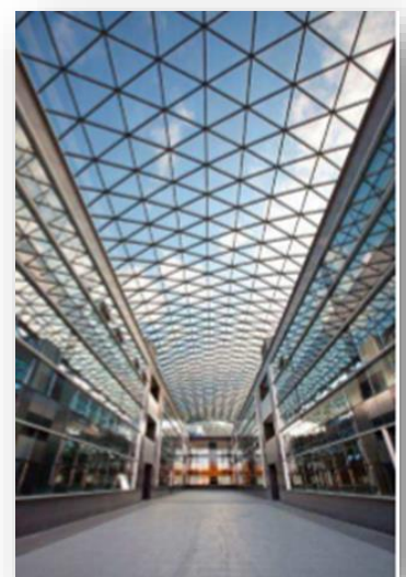
Figure 116 : Toiture tridimensionnelle (Auteur)
