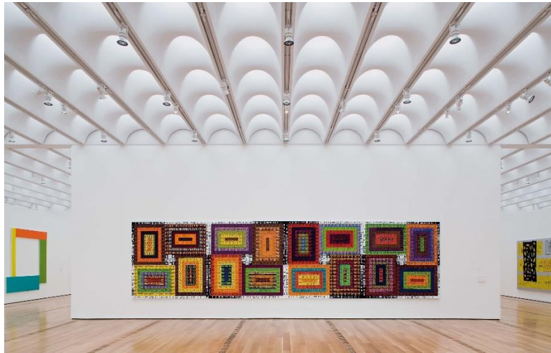
Figure 47: light pipes au musée d'art à Atlanta USA, renzo piano architecte (archilovers.com)
