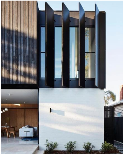
Figure 43: persiennes extérieurs verticaux (Bryant Flink Architecture)
