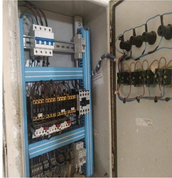
Figure n° 17 : panneau de commande l'éclairage
