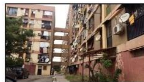
collectif groupé colonial cité les orangeries
