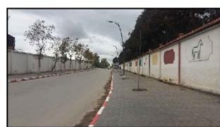
⑤ problème d'imperméabilité sur l'avenue du 11 décembre
