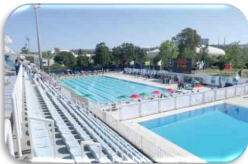
Figure II. 19 : Piscine olympique 5 juillet ALGERIE Source : elmoudjahid.com
