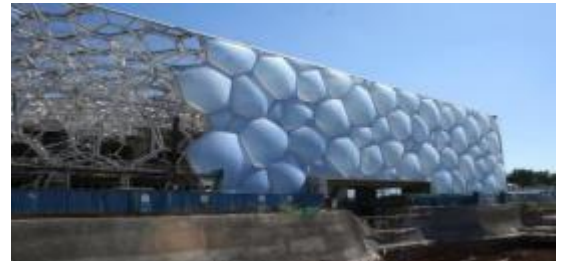
Figure II. 41 : Façade en cours de construction ; Source : An aquatic centre Carmen lazzarotto.PDF
