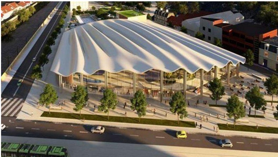
Figure II. 29: Toiture du Complexe aquatique de Reims, au bon cœur (de ville) de Marc Mimram ; Source : Chroniques-architecture.com
