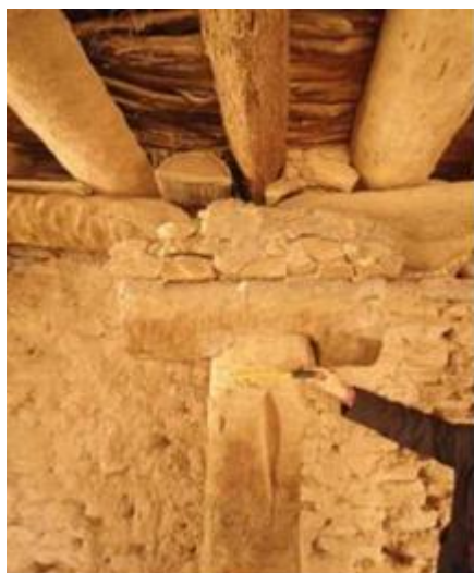
Figure 1.7: Les éléments intermédiaires entre colonne en bois de palmier et couverture, Biskra [98]
