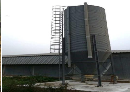
Figure 14 : silos d'aliment (photo personnelle)
