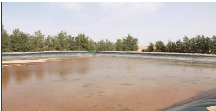
Figure 3. 4: Bassin réservoir de la ferme Ezzahra
