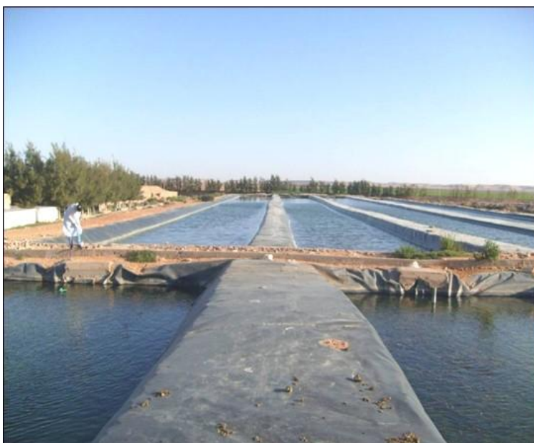
Figure 3. 3: Bassins en géo-membrane de la ferme Ezzahra
