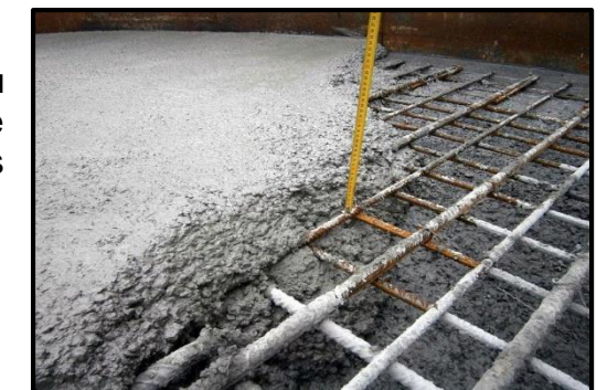
Figure 4.47 : Mise en œuvre du béton armé Source : www.researchgate.net / consulté en
