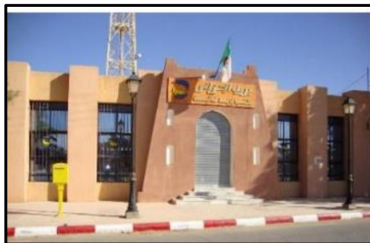
Figure 3.22 : Photo de la poste de Taghit Source : Mémoire : Eco-hôtel à Bechar (Taghit) 2015/2016 / université Blida 1
