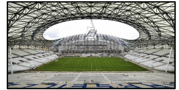
Figure 4.46 : exemple d'une structure métallique en treillis (stade Vélodrome) Source : www.lemoniteur.fr/ consulté en 2019.
