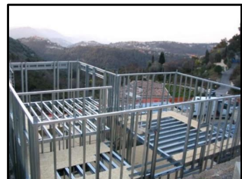
Figure 1.20 : Ossature en acier Source : www.hci-constructions.fr
