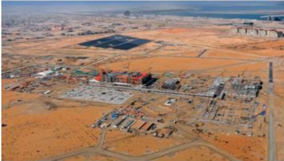
Figure 3-26 : vue aérienne de masdar city en cours de construction Source : Simon Roger "Au milieu du désert, le mirage de Masdar" (Abou Dhabi, envoyé spécial), Le monde,29.02.2016
