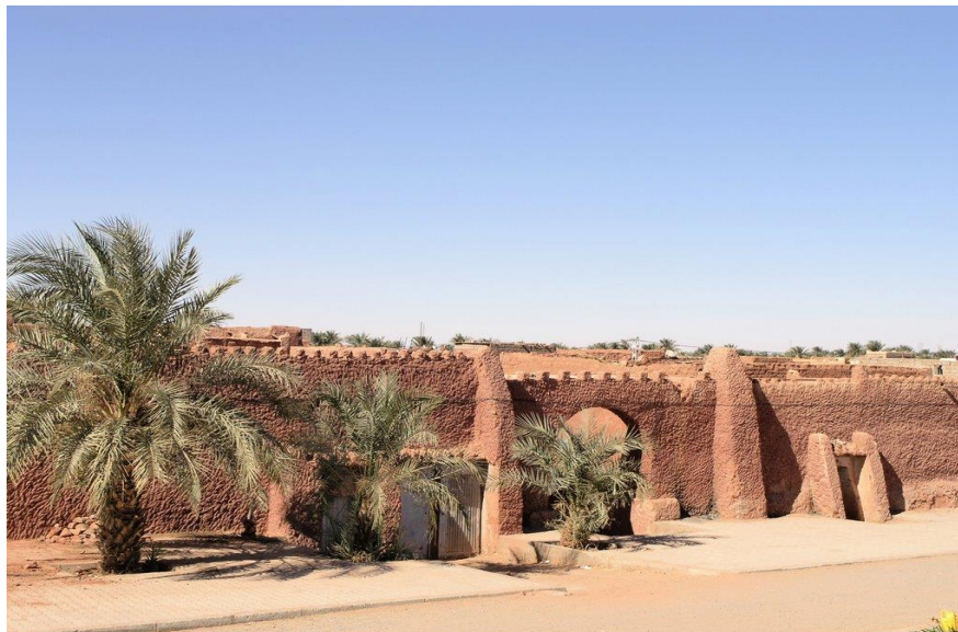
Figure 3-7 : muraille de ksar de Timimoune Source : https://mapio.net/a/114469486/?lang=fr site consulté janvier 2019
