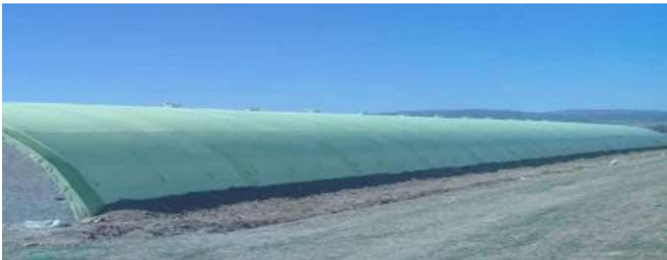
Figure 08 : bâtiment d'élevage privé
