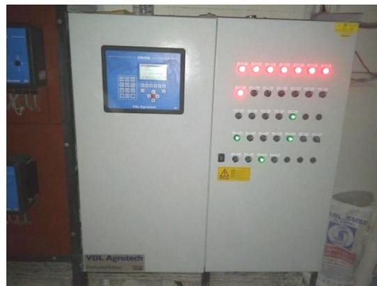
**Figure 11:** Armoire de contrôle des paramètres d'ambiance
