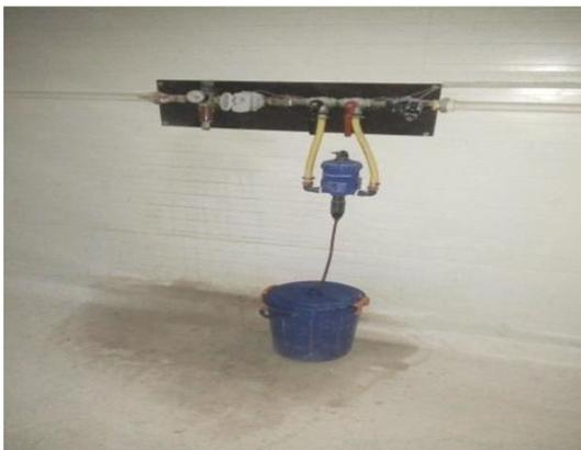
**Figure 10:** Pompe d'aspiration de produits médicamenteux reliée à la conduite d'eau
