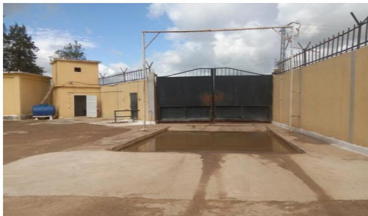
**Figure 6:** Entrée principale munie d'un rotoluve
