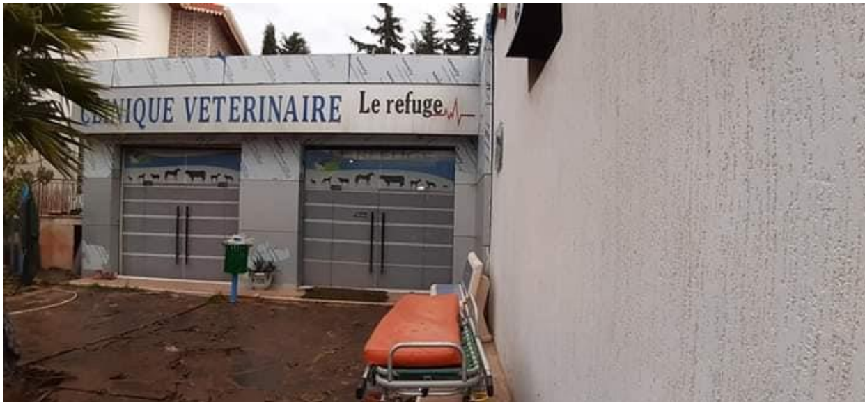
Figure n° 8 : Le centre d'hospitalisation vétérinaire le refuge de Batna (CHV)
