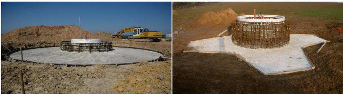
Figure 1.31: La fondation en béton.
