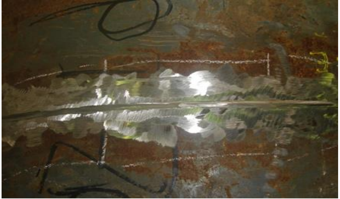
Figure 3.6 : Meulage d'un cordon de soudure
