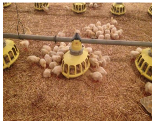
Figure 19 : Chaîne de distribution automatique d'aliment (Bâtiments 2 et 4)
