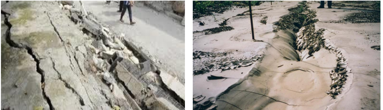
Figure 2.3 : Phénomène de liquéfaction observé lors du séisme Boumerdès 2003 [13]
