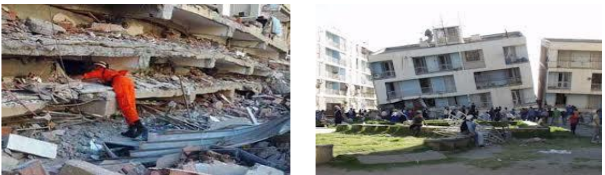
Figure 2.4 : Les effets des éléments structuraux et non-structuraux sur le dommage des constructions lors du séisme de Boumerdès 2003 [13]
