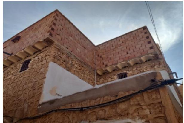
Figure I-17 et I-18 Les élévations en béton et la brique
