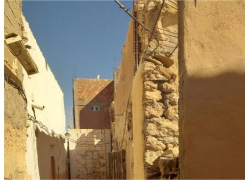
Figure I-79 et I-80 Les matériaux utilisés pour les nouvelles constructions du Ksar
