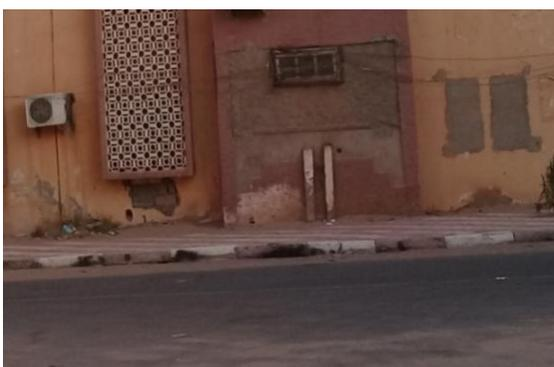
Figure I-62 Ouverture partiellement fermée au niveau d'un logement au RDC
