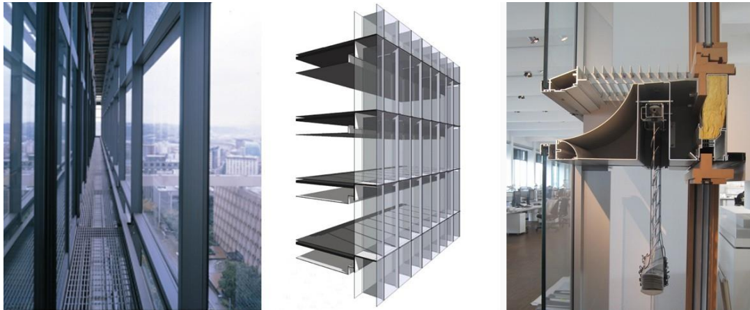
Figure 221: facade double peau source : isolation. ooreka .fr
