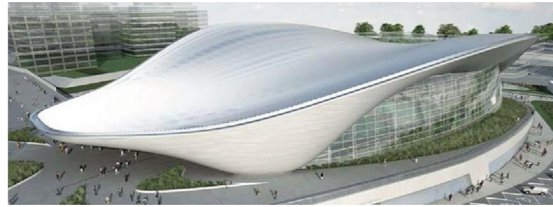
Figure II-63: Vue extérieure du projet.
