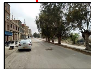
Figure II-19 : ligne de transport de la CW7. Source : Auteur.
