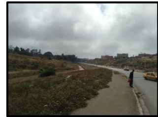
Figure II-16 : ligne de transport de la voie communale
