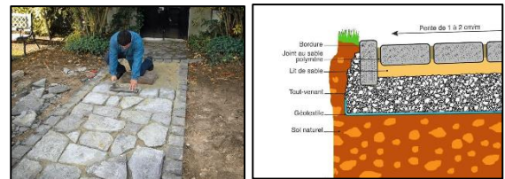
Figure II-105 : : pavage en pierre a joint sabler.
